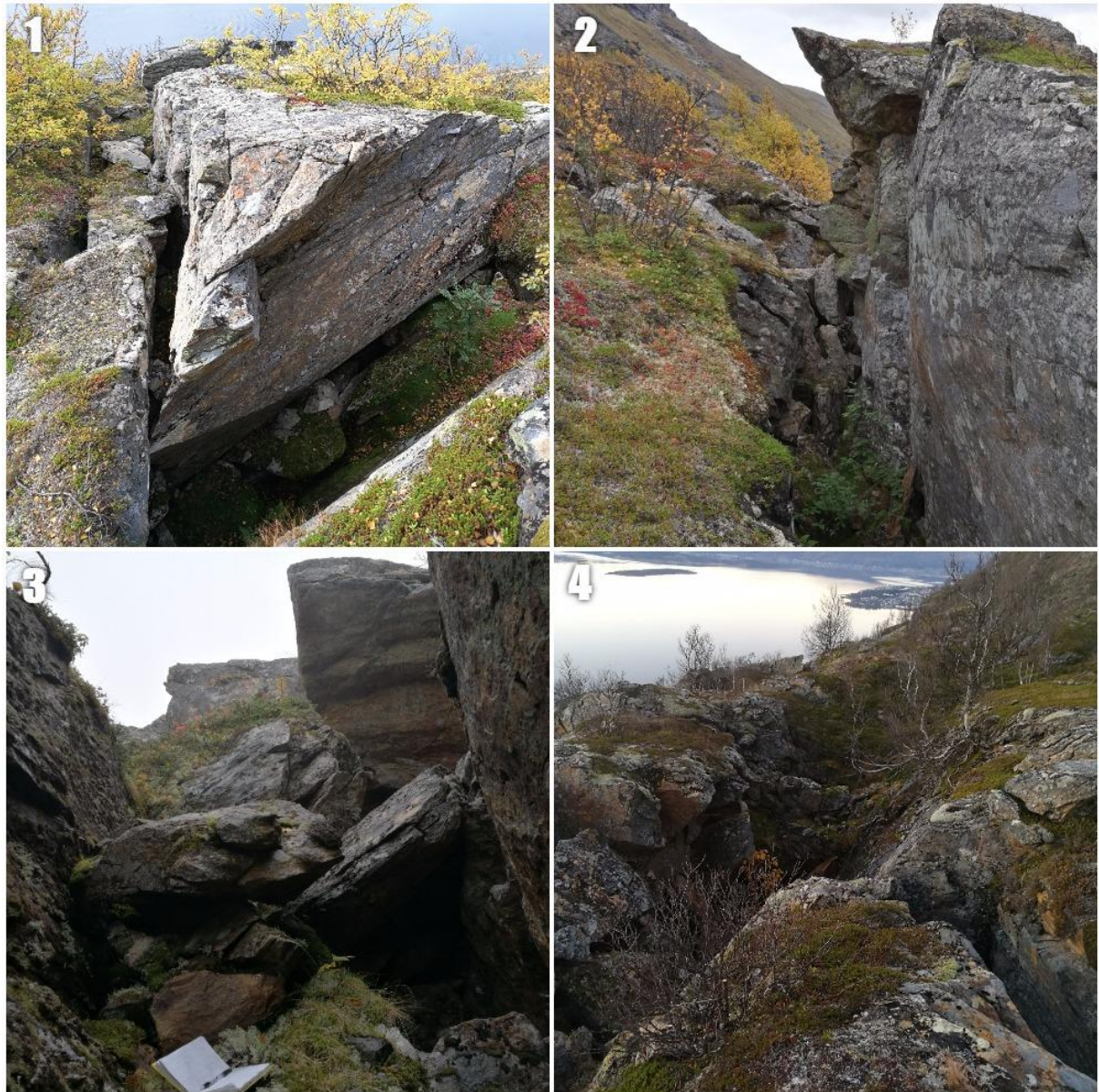
Figur 4-22: Bilder av sprekker ved benken til område A. 1: Ortogonale sprekker som danner et sikksakk mønster, 2: Langsgående sprekk ved vestlig flanke av benkflaten ved område A, 3: store mengder løse blokker i sprekkene, 4: Oversiktsbilde av sprekker, hvor åpningen i midten er 7m.
