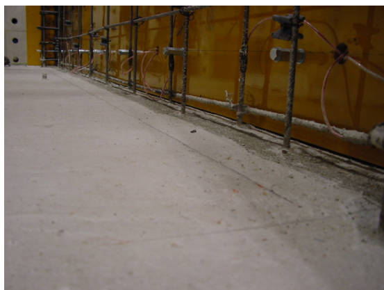
(a) 壁脚部分の目荒らし
