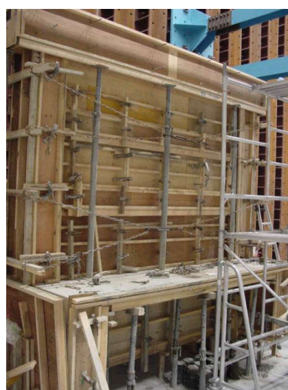
(b) 上部構造打設
