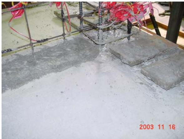
(a) 壁脚部分の目荒らし
