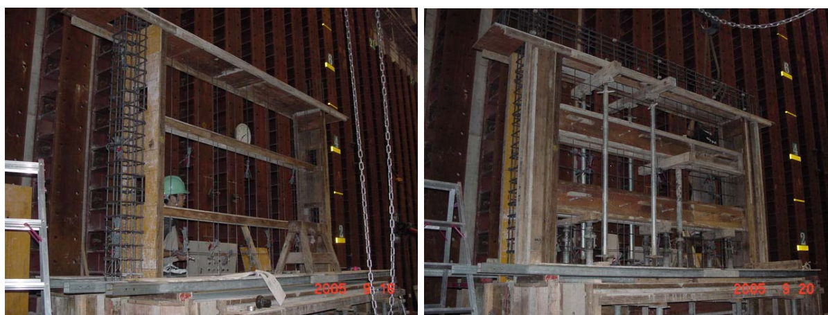
(a) 1回目打設
