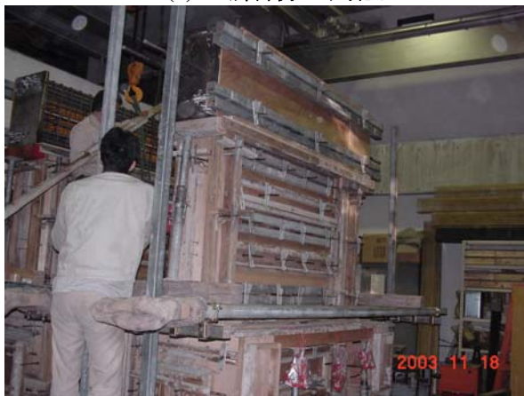
(c) 上部構造打設後
