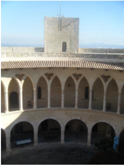
Fig. 3. Decoración de los arcos de las galerías inferior y superior del Castillo de Bellver. Mallorca: Castillo de Bellver. Fotografía del autor del texto. Obsérvese el tejadillo que hace de visera para proteger de la lluvia la galería superior.
