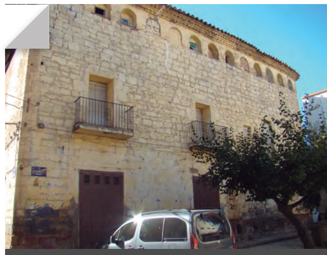
Fig. 1 - Vista general de l'estat actual que presenta la façana del cos de llevant de l'edifici que es correspon amb l'obra del projecte original del segle XVI. (Fotografia M. Monjo-I. Pastor)
