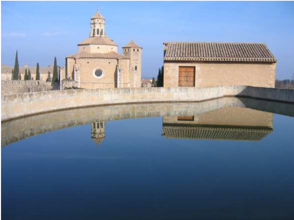
Bassa de l'antic molí hidràulic de Poblet alimentada amb aigua de mines històriques. El molí, ensotat, és l'edifici que despunta a la dreta.
