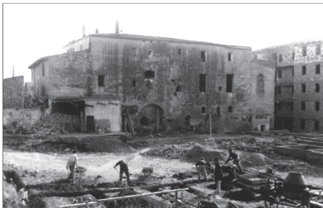
Construcció dels habitatges de promoció pública que reberen el nom de Grupo de Viviendas General Moscardó, aixecats a l'espai que ocupava can Bufalà, una masia que serví d'habitatge a un important nombre de famílies després de la guerra. Es van inaugurar l'any 1956. Museu de Badalona. Arxiu d'imatges. Fons Ajuntament de Badalona.
