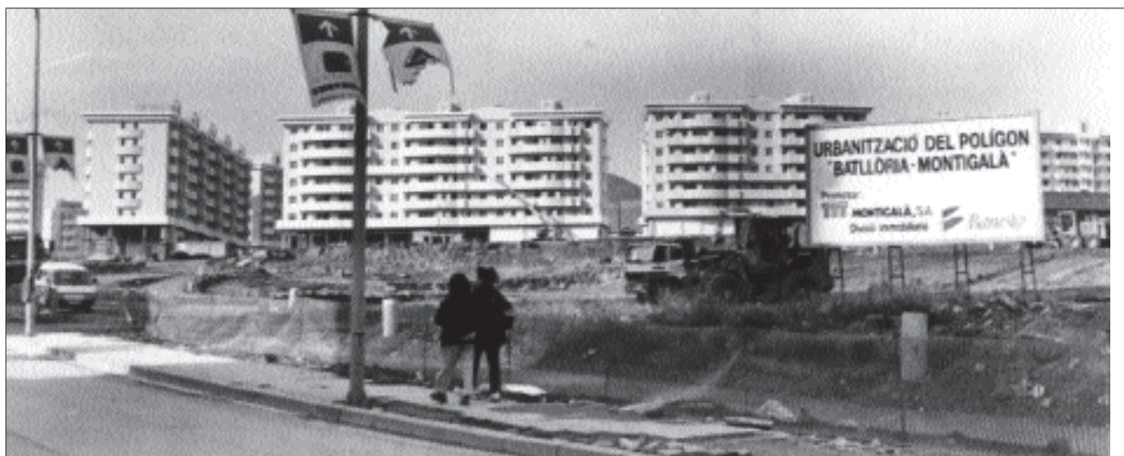
La urbanització definitiva del barri de Montigalà s'inicià uns anys abans dels Jocs Olímpics. La zona s'ha convertit en un espai residencial i comercial que atreu gran nombre de visitants. La fotografia mostra els pisos en construcció que ocuparen els periodistes que cobriren la informació dels Jocs del 92. Museu de Badalona. Arxiu d'Imatges. Fons Ajuntament de Badalona.
