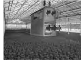
Dibuix d'un calefactor per a hivernacles
