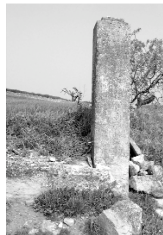
Imatge de l'anomenat Pilar de l'Oratori, en molt mal estat per sobre.
