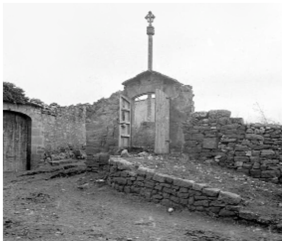
La creu en el seu context original en una imatge de principis del segle XX (fons fotogràfic Salvany de la Biblioteca de Catalunya)
