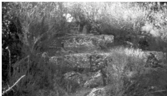
Restes visibles de l'estructura dels Escolans
