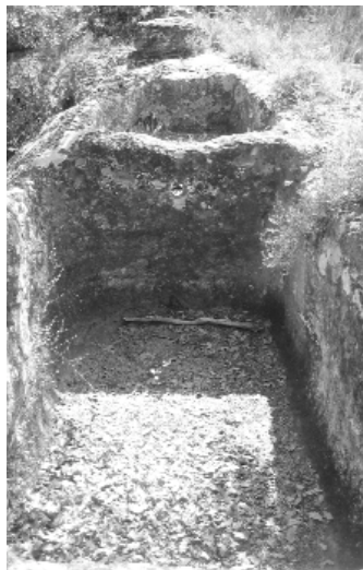
Aspecte actual de les piques
