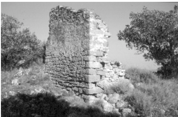
Fragment del mur que suposadament formava part de l'ermita de Sant Cristòfol
