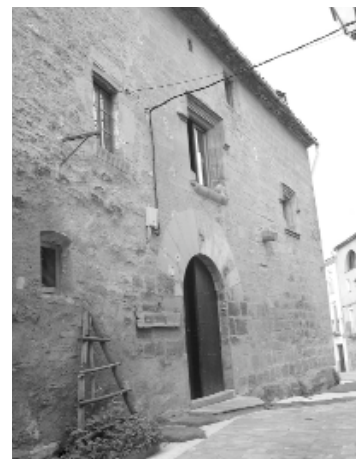
Detall de la façana principal
