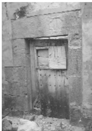
Porta lateral de Cal Xuriguera, ara desapareguda, amb una mà oberta esculpida al dintell
