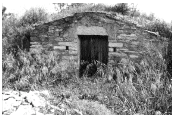
Imatge de la mateixa cabana, obrada en pedra calcària del país. La cabana de volta no és una construcció gens abundant a la zona d'Ivorra
