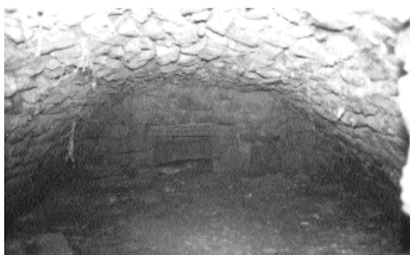
Interior de la fresquera, fet amb volta de canó. La paret posterior presenta un rebuidat que podria fer pensar en un possible desguàs
