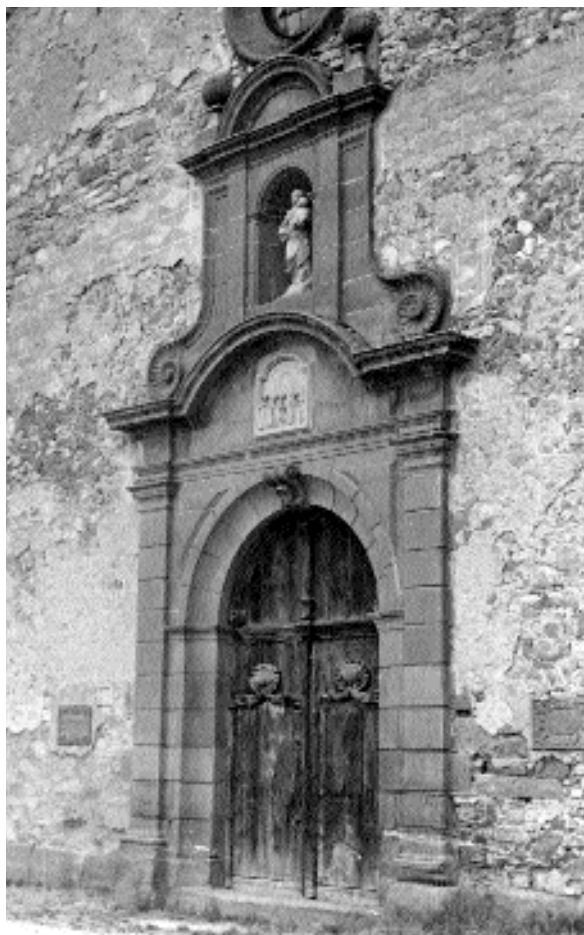
Portada d'accés a l'església en una imatge dels anys seixanta. A la part superior encara s'aprecien restes dels esgrafats geomètrics que decoraven l'arrebossat de la façana (fons A. Duran i Sanpere-AHCC)
