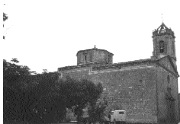
Imatge dels anys seixanta, quan es conservava part de l'arrebossat de la façana de l'església nova de Sant Cugat, i la cornisa superior, recoberta per una motllura avui gairebé desapareguda (fons A. Duran i Sanpere-AHCC)
