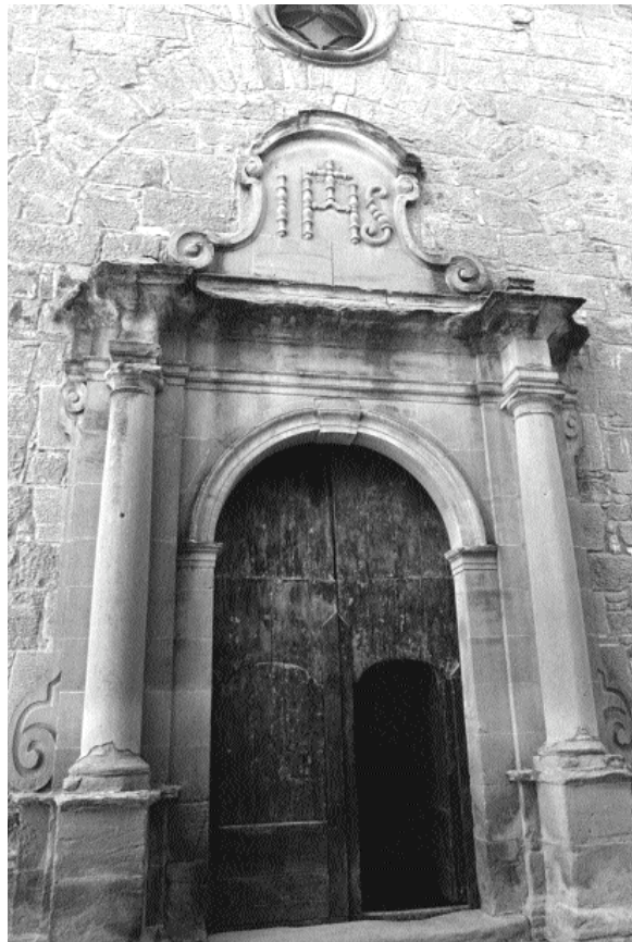
Porta d'ingrés a l'església. Segueix el model d'arc de mig punt flanquejat per columnes sobre podi. A la part superior de l'entaulament apareix el nom de Jesús treballat seguint forma de balustres
