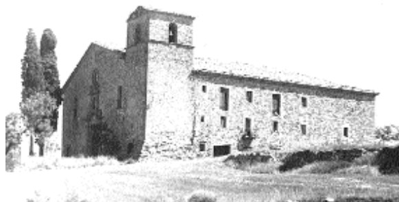
Imatge exterior del santuari i hospederia, que evidencia el seu deteriorament abans de la restauració que es dugué a terme durant els anys noranta (Arxiu fotogràfic de Jaume Coberó)
