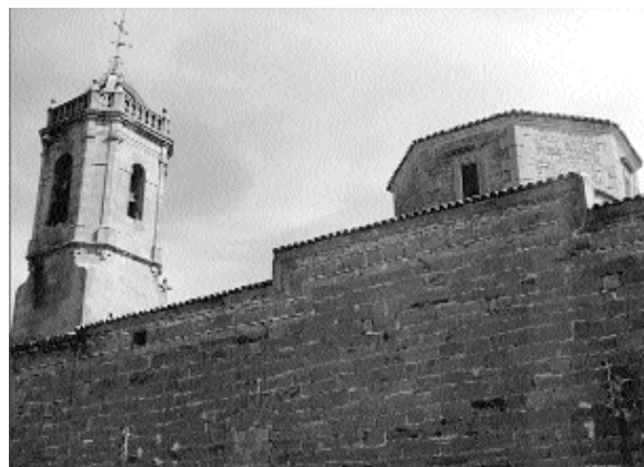
Detall del cimbori vuitavat i del campanar, únics elements que sobresurten del cos rectangular de l'edifici
