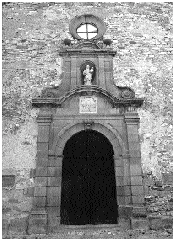
Portada d'accés al santuari. D'arc de mig punt flanquejat per pilastres, destaca la representació del miracle del Sant Dubte al timpà i la fornícula superior amb la imatge de la Verge i el Nen
