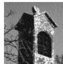
Detall de la fornícula capçada a set vessants amb una bola centrada al carener on es fixava la creu, probablement de ferro
