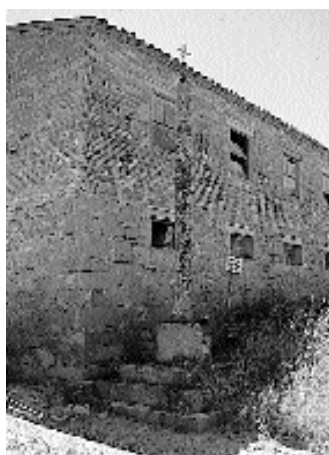
Alçat de la Creu amb el edifici, pràcticament adossats
