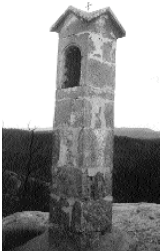
Alçat del pilaret de la Petja coronat per una creu de ferro damunt coberta a vuit vessants
