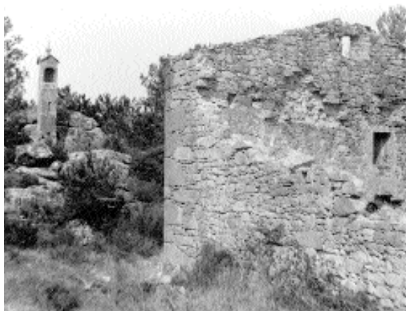
El nom de pilaret de cal Tanyot, que és com hom coneix aquest element escultòric aixecat en la carena de la serra de Cellers, li ve de la casa que hi havia prop d'aquest indret, les restes de la qual encara podem veure en aquesta imatge dels anys vuitanta
