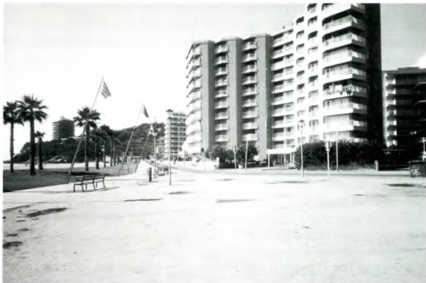
Fotografia 2: No queda res de l'antic paisatge rústec a Torre Valentina
