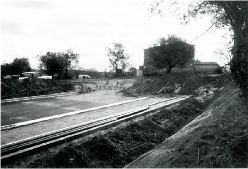
Fotografia 11: La masia dels Vinyers poc abans de ser enderrocada, amb el pretext d'urbanitzar-se el seu sector de Calonge
