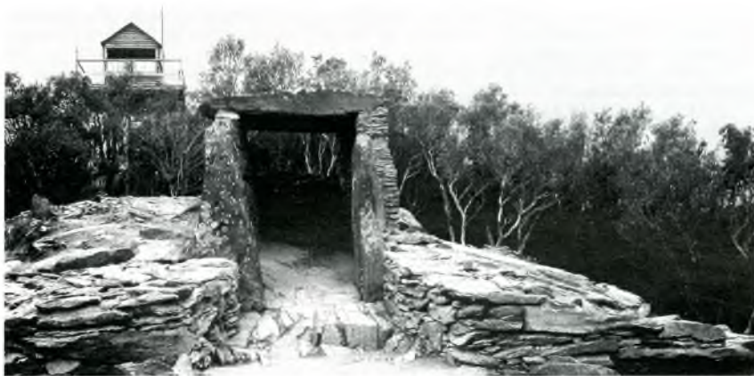
Fig. 6. Vista frontal del dolmen del Puig d'Arques, una vegada restaurat
