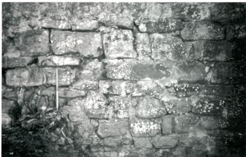
Fig. 23. Detall del mur c del castellum (part inferior de la paret septentrional de la capella de Sant Andreu), on s'observa, intacta, l'obra carolíngia.
