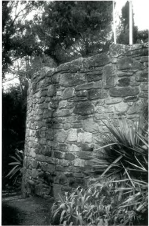
Fig. 25.- Torre A del castellum . La part de dalt és obra nova del moment d'adequació del parc arqueològic. S'observa, en la part original, algun dels orificis rectangulars que hem suposat encaixos de la bastida de l'obra carolíngia.
