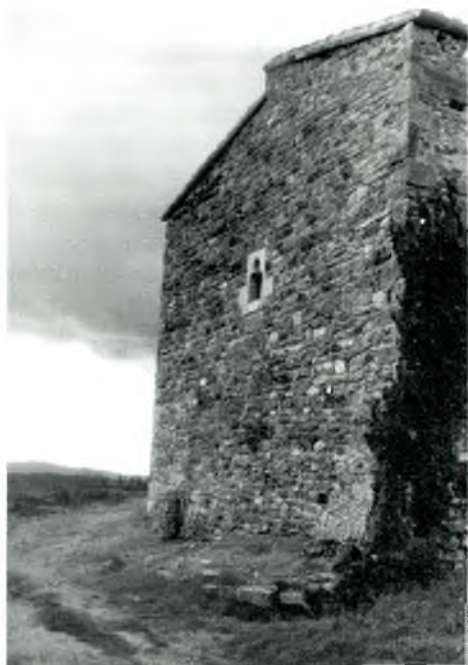
Fig. 22. Fotografia de 1959. Costat oriental de l'acròpoli i de l'antiga capella tardogòtica de Sant Andreu. A l'angle inferior de l'edifici s'observen les ruïnes de la torre C del castellum , tal com es van trobar (clixé del Museu d'Arqueologia de Catalunya-Ullastret).
