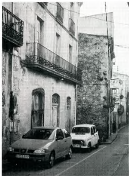
Fig. 4. Casa de Baldiri Viladesau (carrer Major)
