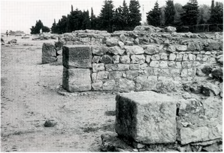
Fig. 22. Detall dels daus situats a l'extrem dels murs de sustentació de les grades de l'amfiteatre emporità.
