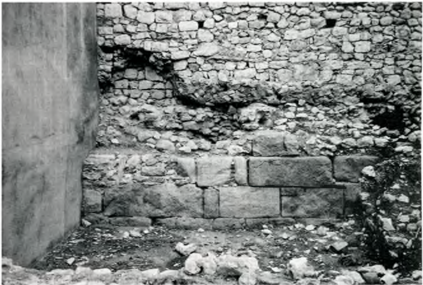
Fig. 17. Vista de la muralla tardoromana de Sant Martí d'Empúries, bastida amb grans carreus paral·lelepèdics, ben diferent de la muralla posterior que s'aixeca al seu damunt.
