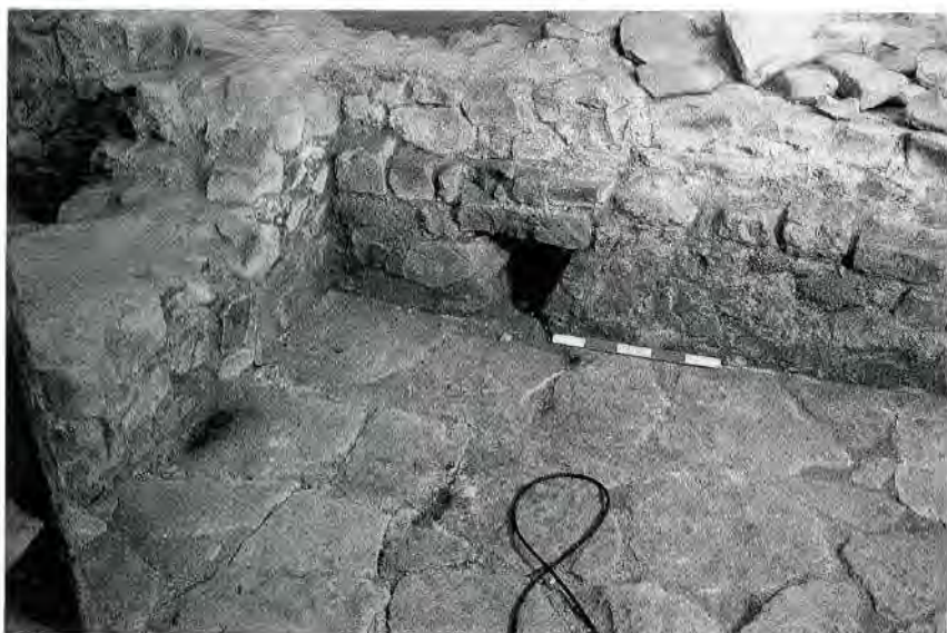
Fig. 12. Paret que separa el frigidarium (àmbit A) del tepidarium (àmbit B) amb el forat de desguàs de les aigües residuals.
