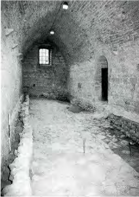
Fig. 1. Vista del conjunt de la caval·lerissa, presa des de l'angle S-O de la sala.
