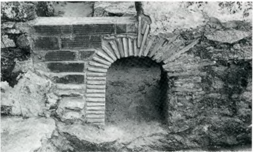
Fig. 42. Paret oriental de l'estança H. Arc de rajols, restaurat; havia estat romput en fer el desguàs que es veu a la part alta, entre l'església i la paret ara eliminada.
