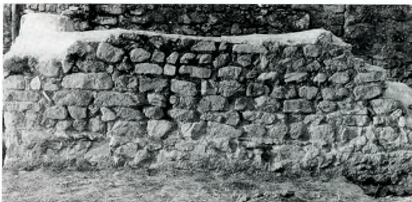
Fig. 44. Paret nord exterior de l'estança H. De la banquetta a la part inferior dels fonaments hi ha 70 cm i a l'extrem superior 115. L'aparellat és de filades de pedres sense escairar. A darrer terme, la paret de l'església.
