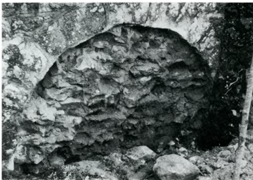
Fig. 32. Fotografia antiga del portal que uneix l'església pre-romànica amb les actuals restes excavades. Aleshores no era possible retratar-lo tot, perquè la paret que aguantava les terres —es veu a primer terme— ho impedia. La remarcable amplària de l'arc fa que les dovelles no siguin massa pronunciades. L'obertura només era —i és— tapada del costat de l'església de Santa Maria.
