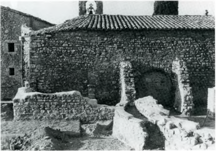
Fig. 41. El conjunt, ja net, es veu amb tot detall. A primer terme —començant per l'esquerra— la paret de l'estança H, la circular i la romànica. Al centre, la rectoria, l'absis, el muntant que, interiorment, es correspon amb l'arc triomfal i que separa l'absis esmentat (a l'esquerra) i la nau (a la dreta); també dos contraforts i, entre ells, la porta de la qual he parlat repetidament.
