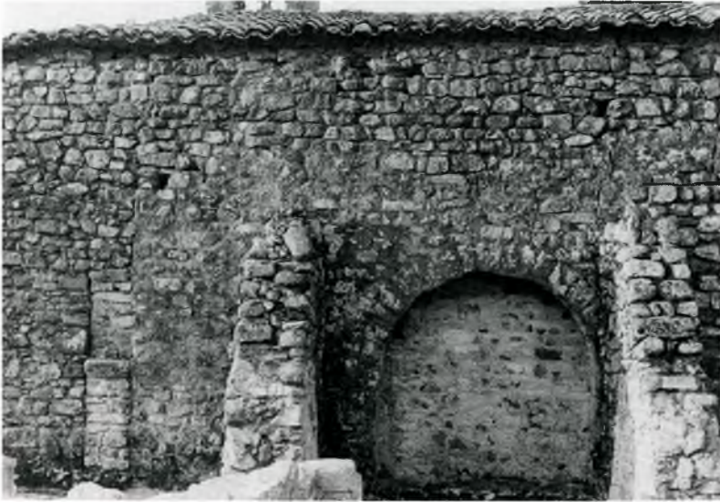
Fig. 40. En aquesta fotografia es veuen el muntant encastat entre l'absis i la nau; el conjunt del parament —alterat a la part alta i autèntic a la baixa— i els dos contraforts. També la porta per la qual es passava d'una església a l'altra.
