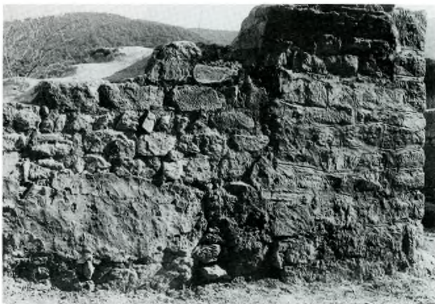
Fig. 46. Paret nord interior de l'espai H'. A la dreta, el parament presenta incissions a l'argamassa; pertany a l'esglésiola romànica. Al centre i a l'esquerra l'aparell és més bast, fet a base de filades de pedres sense escairar que havien estat arrebossades (encara se'n veu un bon fragment); pertany a l'edificació circular. La unió d'ambdós tipus de paret és ben manifesta. A 1,30 m d'alçària de la part romànica hi ha un arrencament d'arc que s'avé amb un altre de la paret oposada (església de Santa Maria).
