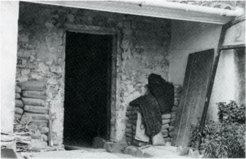
Fig. 12. La mateixa obertura des de l'exterior. El porxo, amb bigues de pòrtland, havia estat fet el 1951; a la dreta de la fotografia, recolzada a la paret, hi ha la porta ja treta. L'obertura original probablement era en aquest mateix lloc, més petita i de punt rodó; per tant, la paret propera no pot ser l'autèntica.
