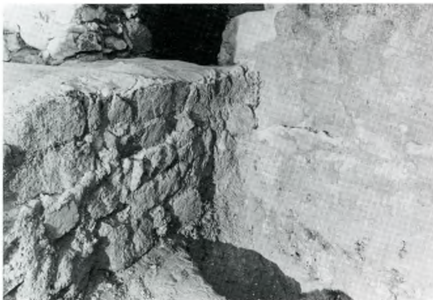
Fig. 45. A l'esquerra, la mateixa paret es veu trabada a la circular (part baixa del centre de la fotografia) perquè són d'una mateixa edificació; en canvi és desenganxada de les restes romàniques (part alta del centre dreta).
