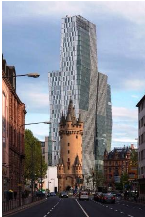
L'antic i el modern, al centre de Frankfurt
