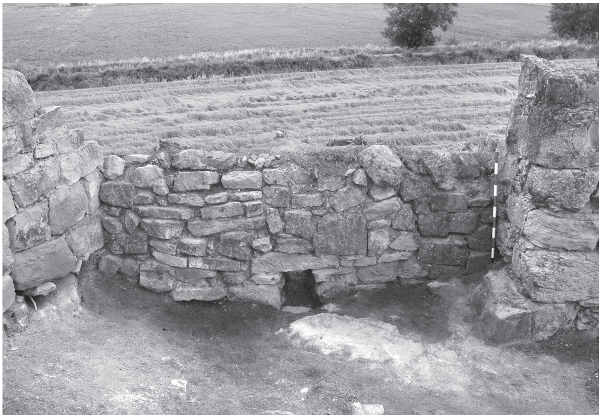
Fig. 14. Detall de l'estructura del tapiat de la porta 7 des de l'interior, amb els carreus de la cantonada corbats i una pedra a la base que funcionaria com a guardacantó.
