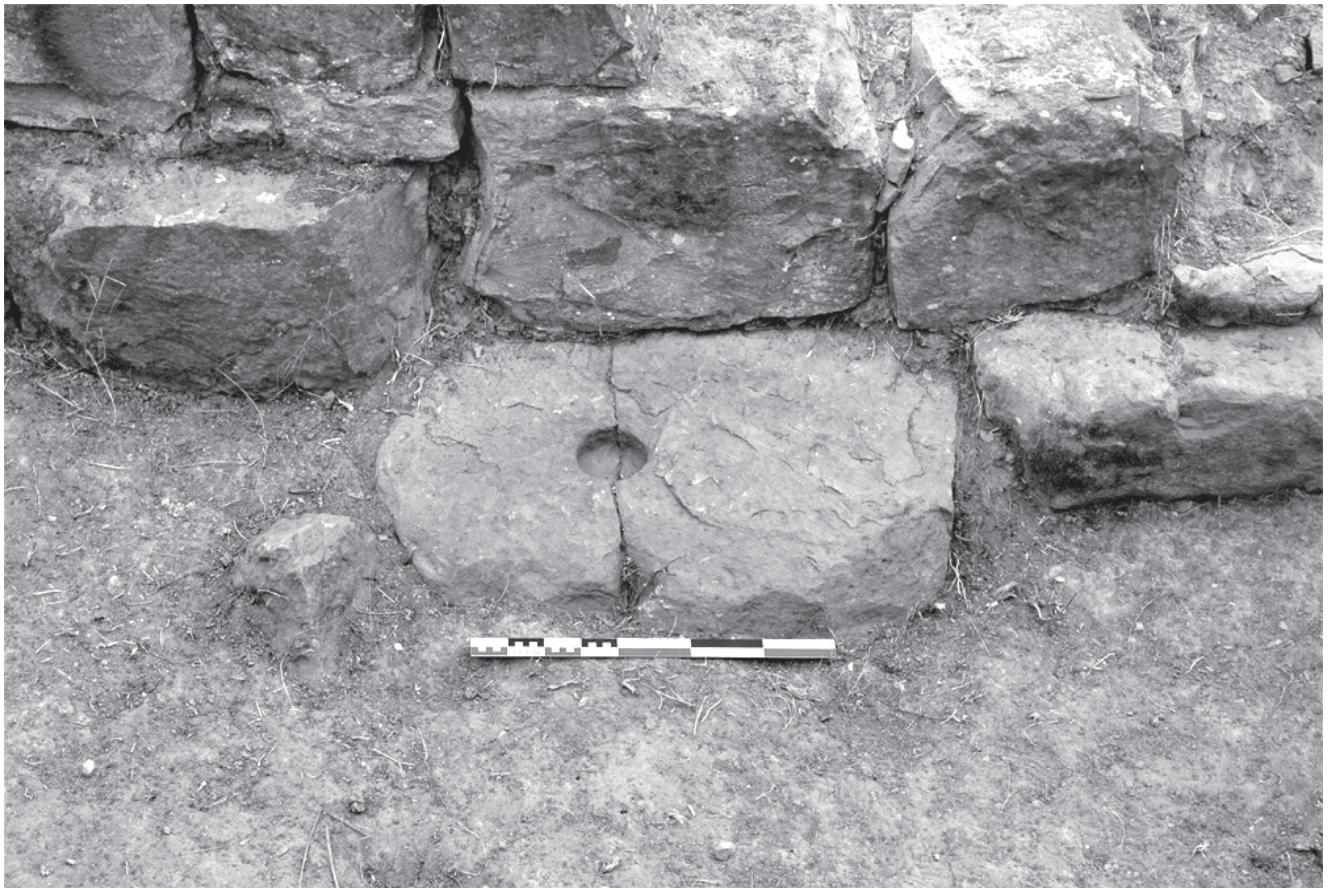
Fig. 12. Detall de la polleguera localitzada in situ al costat est del corredor d'accés a la porta 6.
