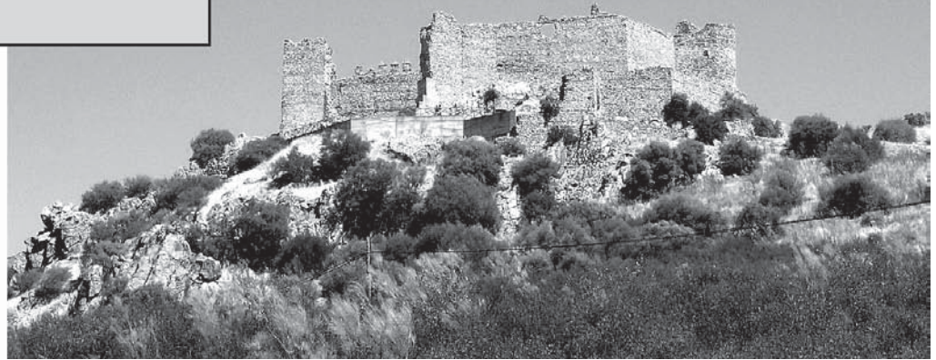
Figura 1. Vista del castillo desde el paso de la vía Dalmacia por el desfiladero.
