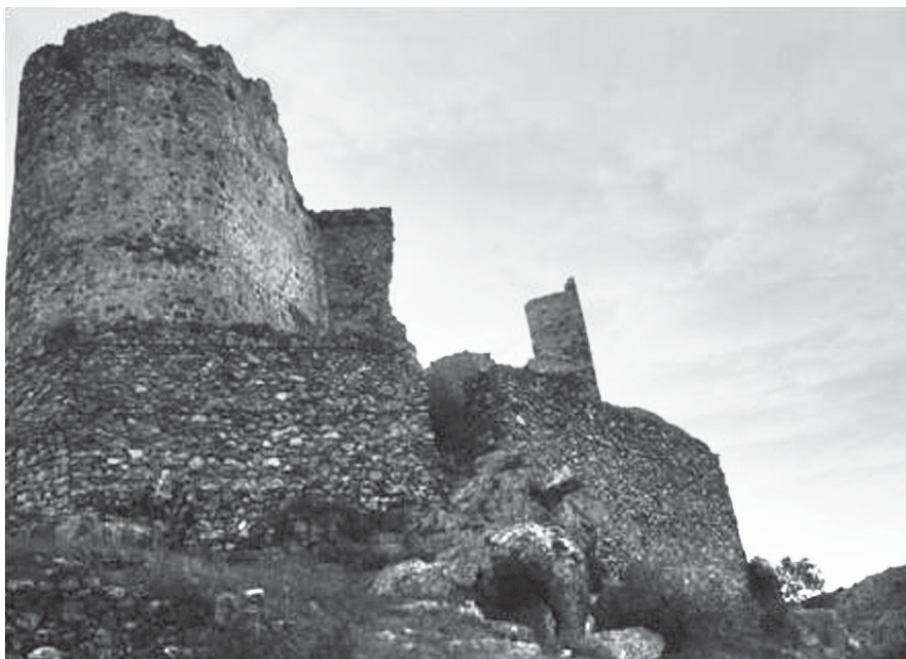
Figura 3. Aspecto actual de la denominada puerta Falsa.
