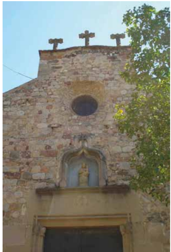
Fot. 16. Estat inicial de la façana
