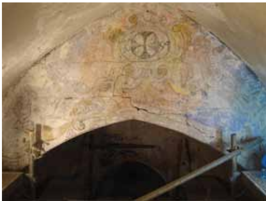
Fot. 6b. Estat durant el procés de descobriment.
