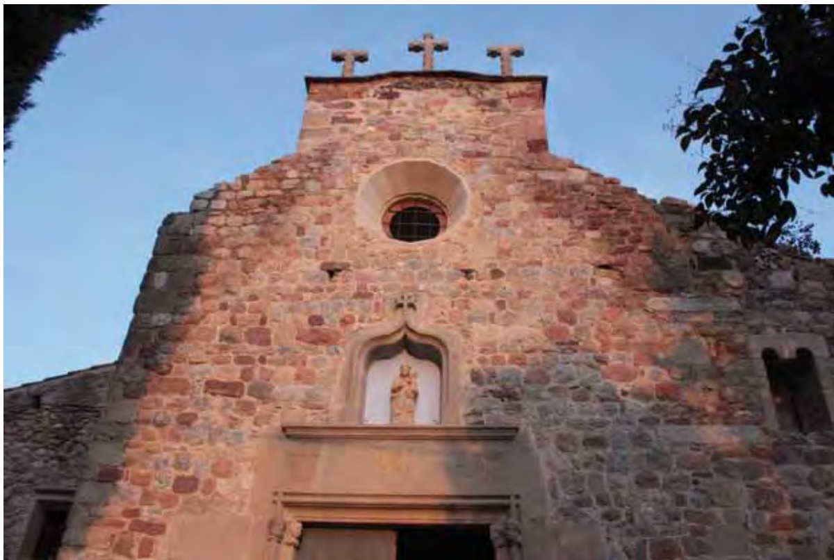
Fot. 17. Façana principal ja restaurada
