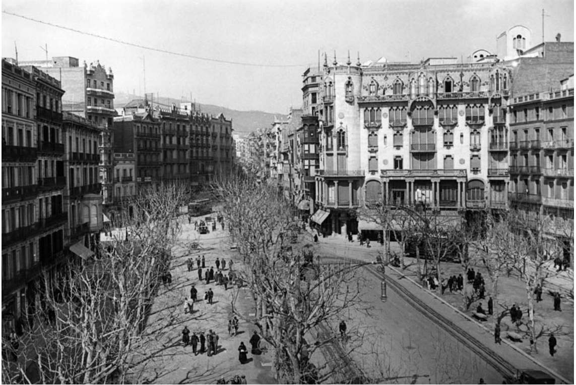
Fig. 5. Vista panoràmica dels Jardinet de Gràcia, c. 1920. La tienda Cassadó & Moreu estava situada en el número 128, muy pròxima a la Casa Fuster. Fotografia: J. Domínguez. © Arxiu Fotogràfic de Barcelona.
