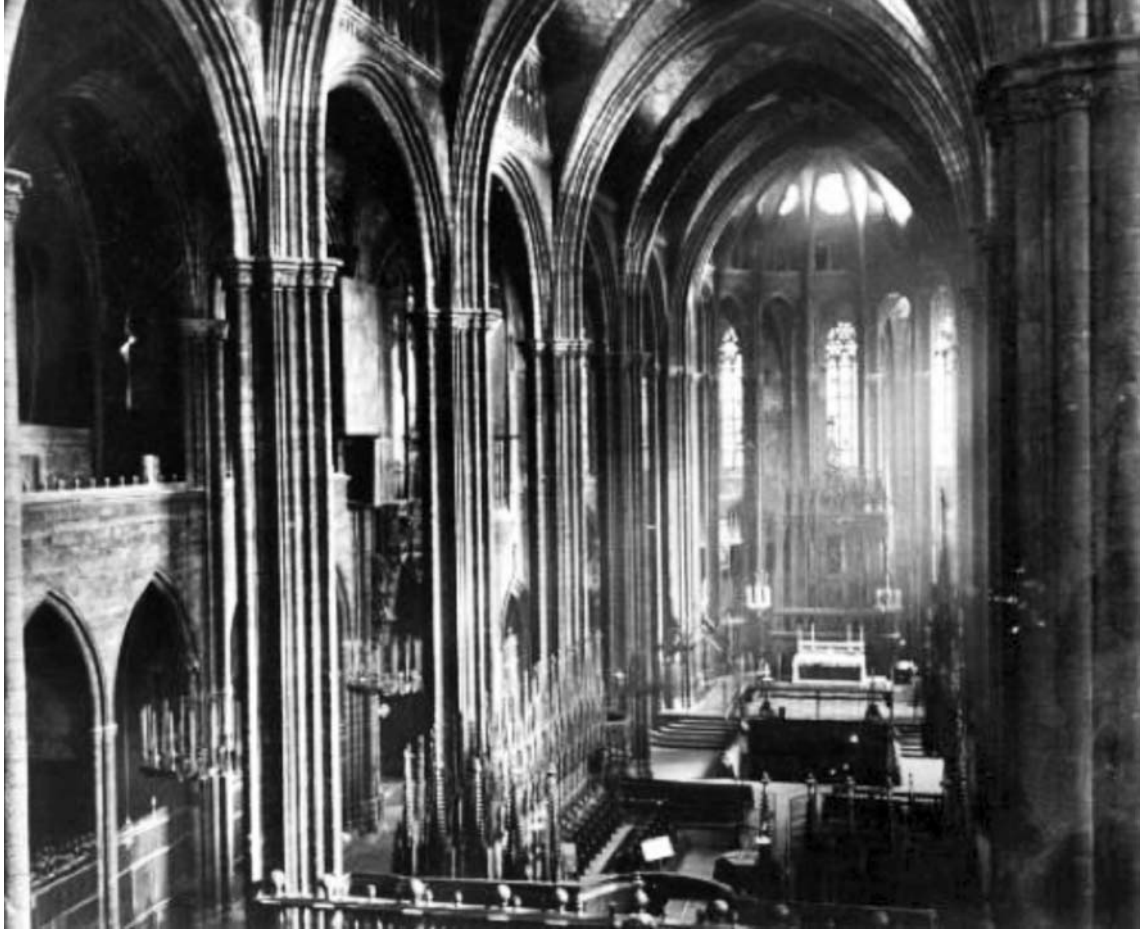
Fig. 3. Nau central de la catedral. De les catedrals gòtiques, Gaudí destacava que “l’arc del cercle de les voltes és gairebé parabòlic”. Les columnes esdevenen arbres fruiters que seran plasmats en visibles cistells en l’exterior de la basílica de la Sagrada Família.
