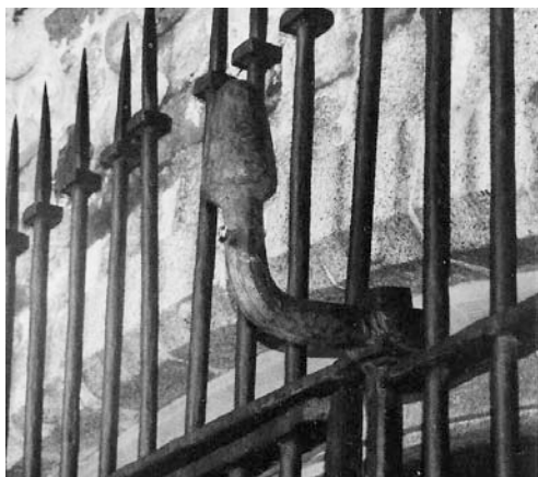
Fig. 4. Detall de la reixa del portal del Claustre de la Seu d'Urgell. Fotografia: Lluïsa Amenós.
