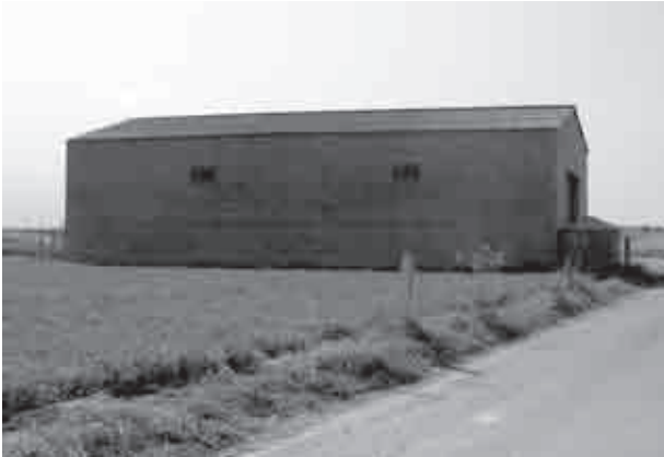
Nau de tàpia de formigó a Barbens.
