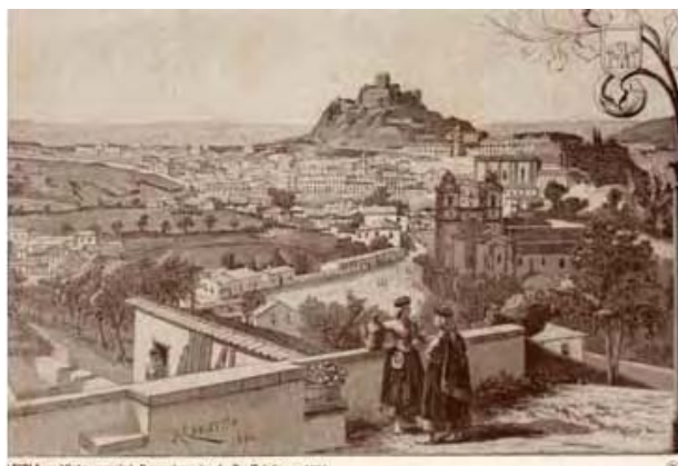
Fig.2 - Vista geral de Leiria em 1864 Fonte: Câmara Municipal de Leiria
