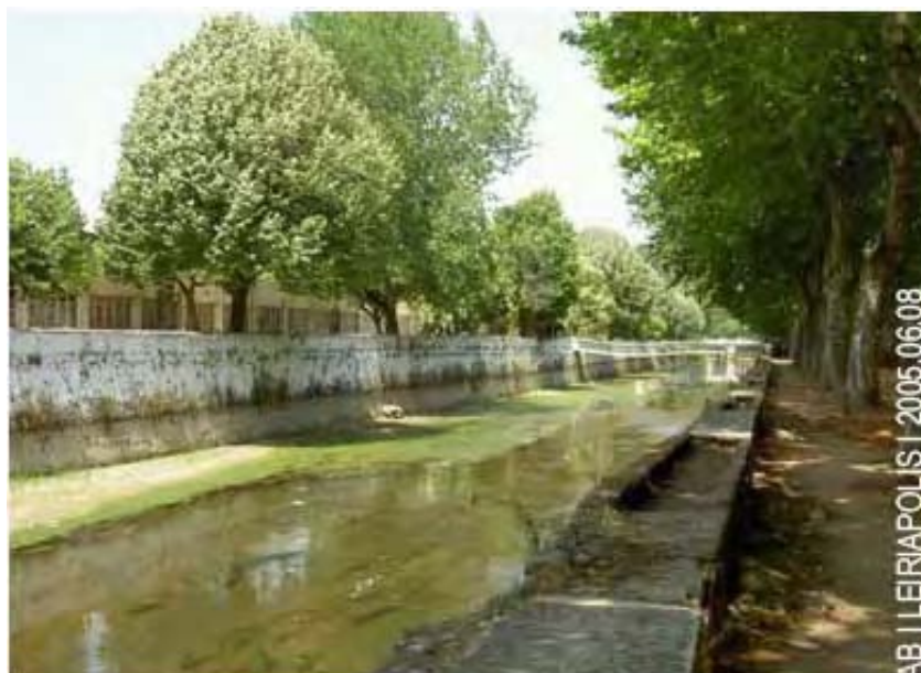
Fig.7 - Percurso artificial do rio Lis entre os muros de contenção.
