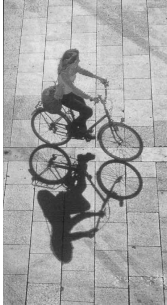
Pavimento de losas de granito en la Plaça Nova de Barcelona
