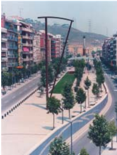
Vía Julia, ejemplo paradigmático de los nuevos espacios públicos barceloneses que se inician en 1980. Obra del Servei de Projectes i elements urbans del Ayuntamiento de Barcelona: Ramón Sanabria, Pedro Barragán, Bernardo de Sola y Josep María Julia con Lluís Mestras, incluye las esculturas de Sergi Aguilar y Antoni Rosselló.
