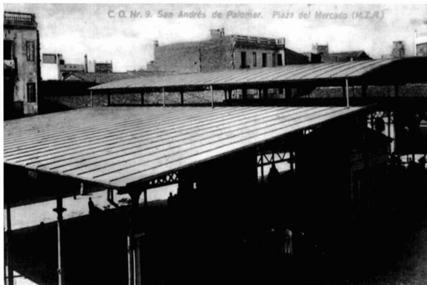
Plaça Mercadal. La coberta metàl·lica tal com era abans de construir les parets que envolten tot el clos.
