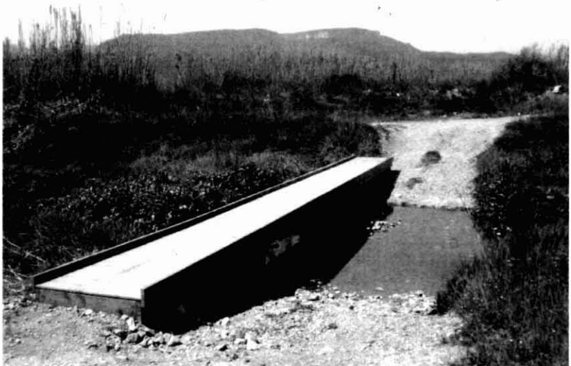
Figura 7. Passarel·la de fusta sobre el riu Francolí.
