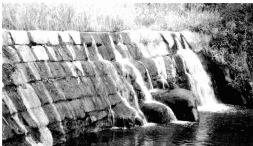
Figura 2. Resclosa al riu Francollí
