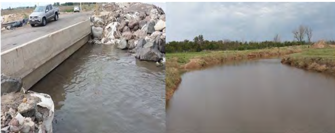
Figura 15. Lugar de salida de agua de la laguna (imagen izquierda) y ambientes generados por el canal en su recorrida hasta la estación de bombeo (derecha).
