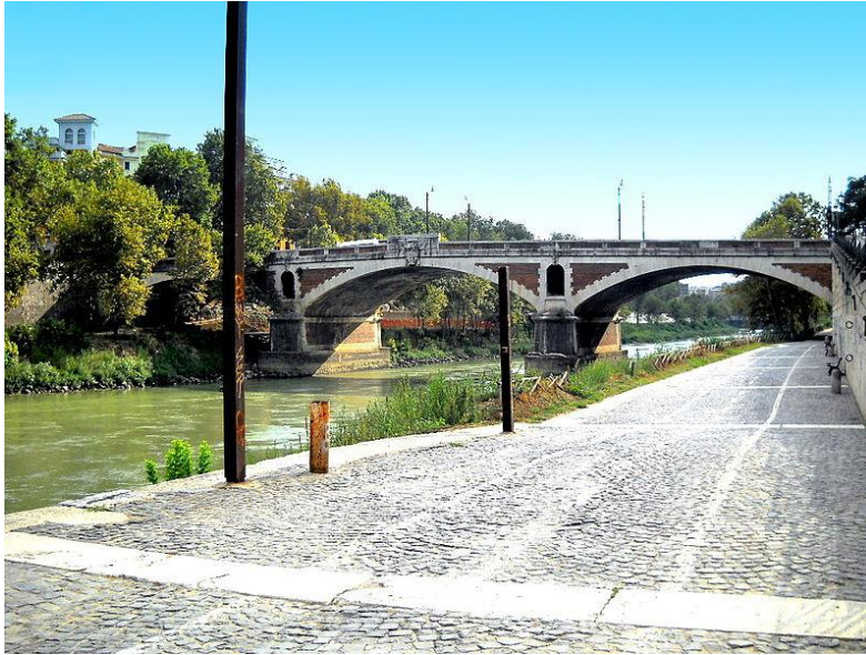
Figura 5 -Ponte Sublício atualmente (Gobbler, 2009).
