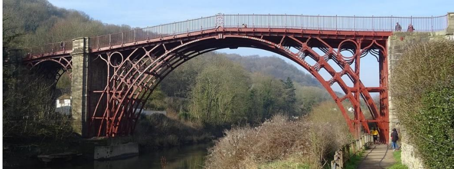
Figura 14 - Primeira ponte em ferro do mundo após a restauração de 2018 (Tk420, 2019).
