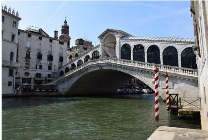
Figura 11 - Ponte de Rialto, Veneza (Bernabei et al., 2019).
