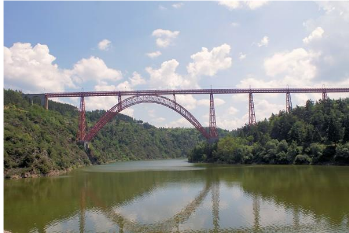
Figura 22 - Garabit Viaduct (Nicolas Janberg, 2009).
