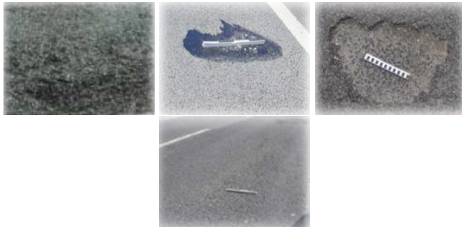
Figura 2.8: Representação dos tipos de deformações (Desagregação superficial, Ninhos, Peladas e Polimento dos agregados, em sentido horário) (Oliveira Maganinho, 2013)
