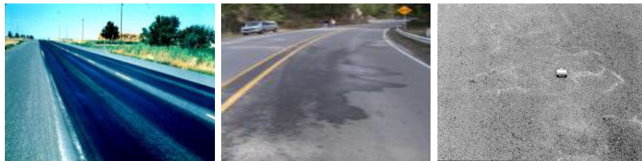
Figura 2.9: Representação dos tipos de movimentos de materiais (Exsudação, Mancha de humidade, Subida de finos, em sentido horário) (Maia, 2012)
