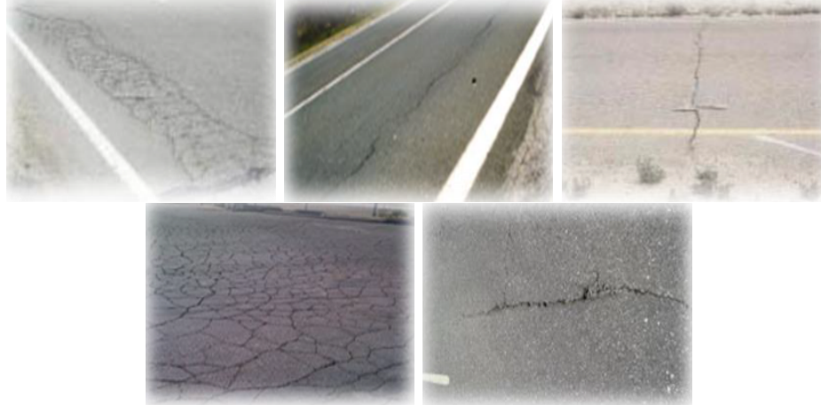
Figura 2.5: Representação dos tipos de fendilhamento (Fadiga, Longitudinal, Transversal, Pele de crocodilo e Parabólicas, em sentido horário) (Oliveira Maganinho, 2013)
