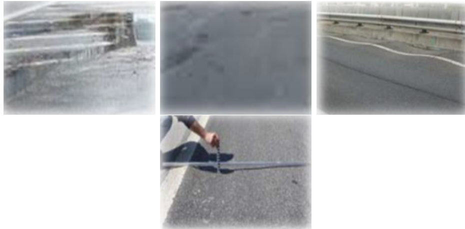
Figura 2.7: Representação dos tipos de deformações (Abatimentos, Deformações localizadas, Ondulações e Rodeiras, em sentido horário) (Oliveira Maganinho, 2013)
