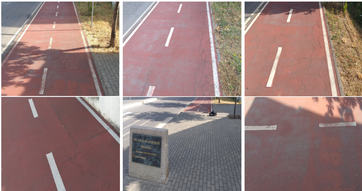
Figura 5.23: Fotografias do estado das Redes pedonal e ciclável do Trecho 2 (Autoria própria)
