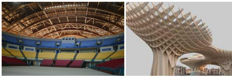
Figura 5 – Cobertura do Pavilhão Atlântico, Lisboa, (esq.), [33] / Metropol Parasol, Sevilha, (dir.), [32].
