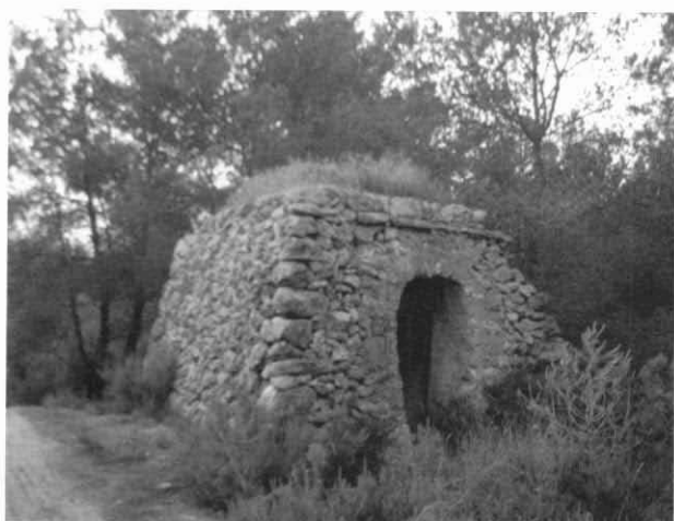
Les barraques de pedra seca
