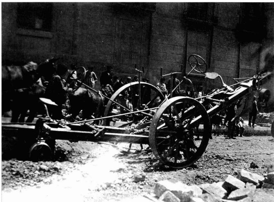
Màquina emprada en la pavimentació dels carrers de Reus.
