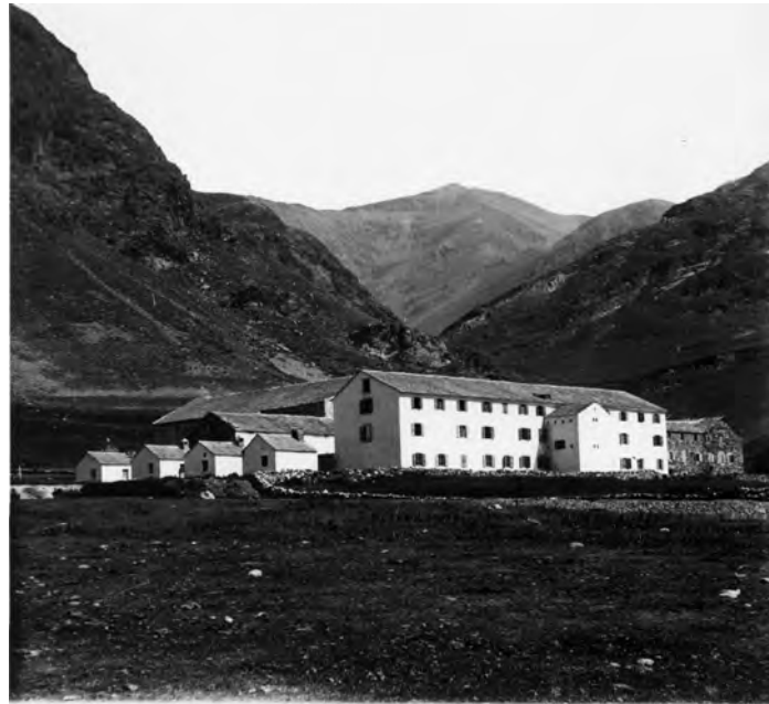
Vista general del conjunt d'edificis que envolten el santuari de Núria, abans de la reforma i ampliació de Josep Danés. Anterior a 1920. (Rafael Masó. AHCOAC-Girona. R. 22978)
