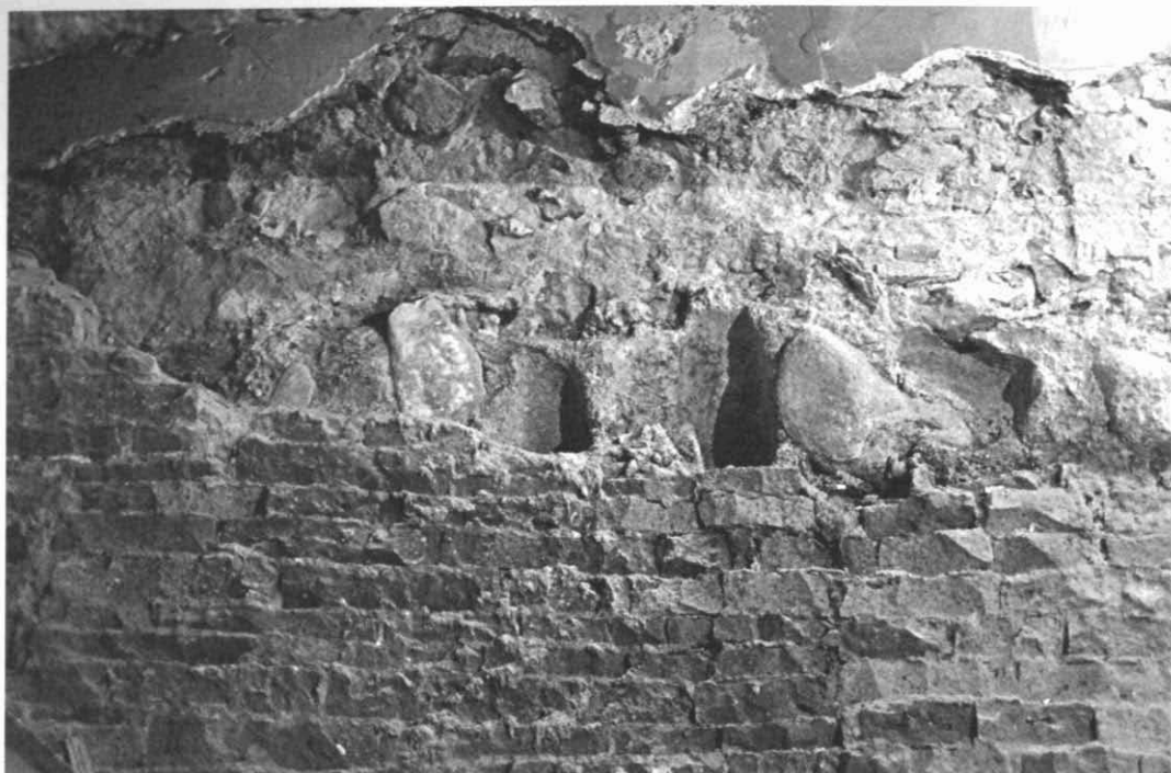
Fotografia 5. Filera de grans còdols que es correspon amb el basament de la muralla. Autors: Eugeni Junyent i Maica Carmona.
