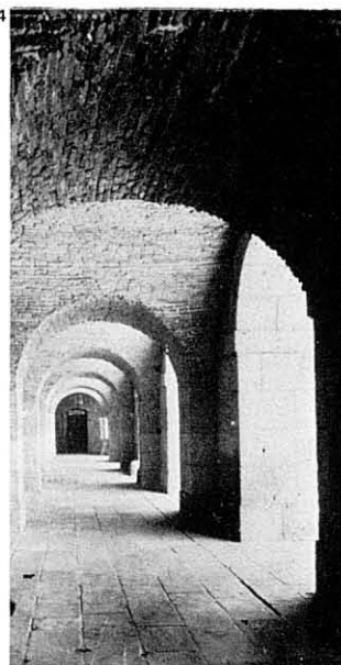
14. Voltes de maó a plec de llibre al pati del castell de Montjuïc.
