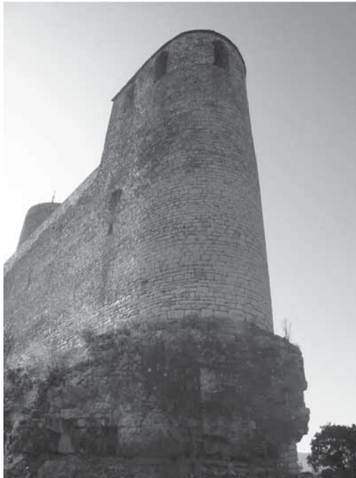
Ilustración 2: El zócalo rocoso del castillo de Mur presenta signo evidentes de la extracción de piedra realizada con motivo de su construcción (SANCHO, 2008)
