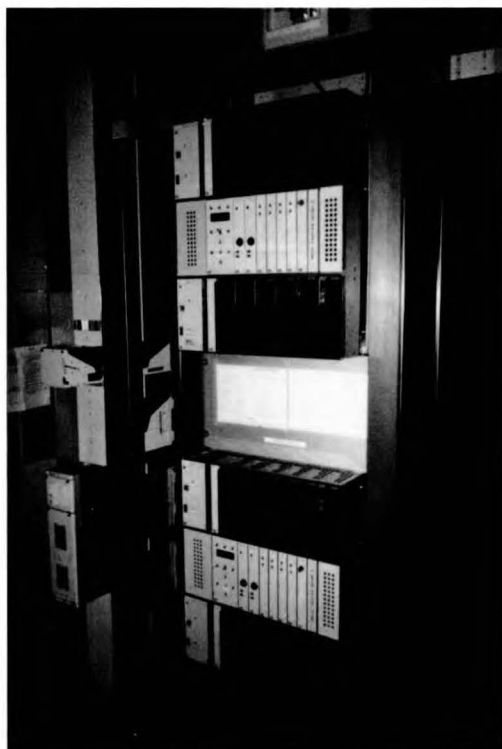
Equipos de desmultiplexación de las señales telefónicas que llegan al Centro.
