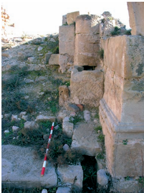
Figura 19. Vista des de ponent del baixant d'aigua localitzat al pati.
