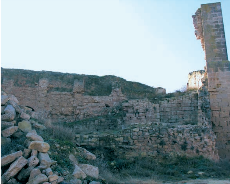
Figura 36. Vista del llenç de tramuntana del castell. S'observa com la cara exterior del mur del celler ha estat completament descarnada.
