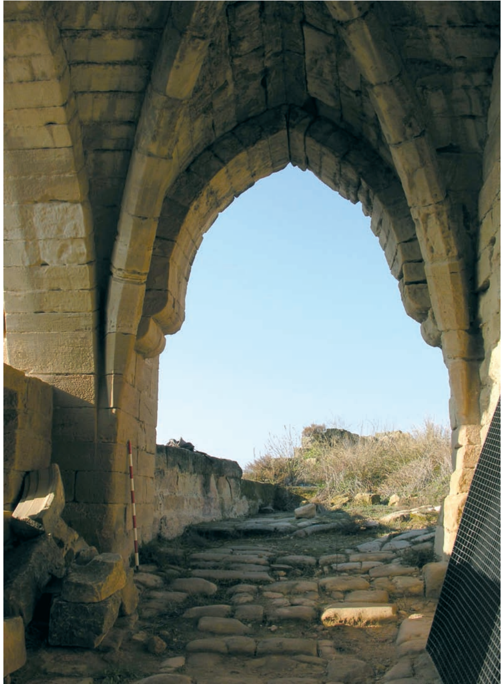
Figura 13. Vista des del sud-oest del pati del castell.
