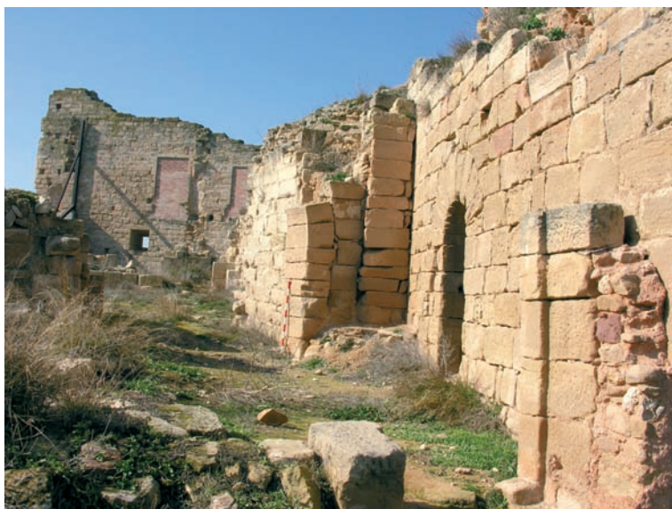
Figura 21. Detall dels brancals de tramuntana de les dues portes que permetien anar del pati a l'àmbit M, passant per la meitat nord de l'àmbit N. Es pot veure com s'adossen a la torre quadrada.
