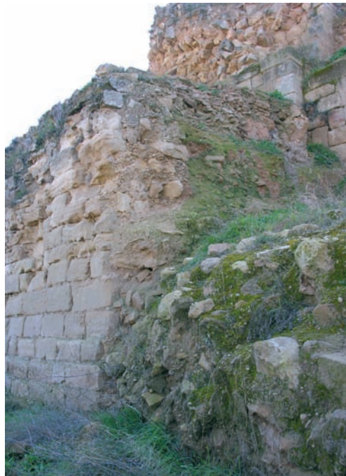
Figura 36. Vista del llenç de tramuntana del castell. S'observa com la cara exterior del mur del celler ha estat completament descarnada.
