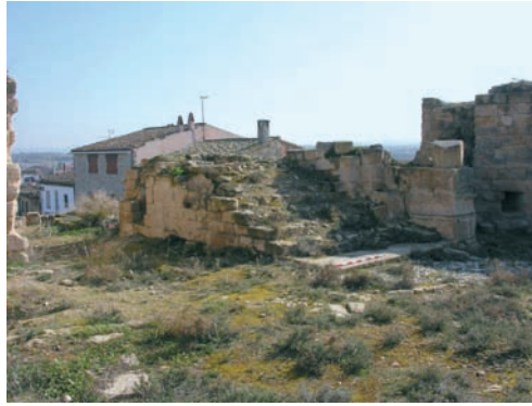
Figura 15. Vista del passadís que comunica l'àmbit B, o pati, amb l'àmbit N, entre el perímetre de migdia del recinte i la caixa d'escala. S'observa el límit de migdia de la caixa d'escala, format per tres paraments diferents.
