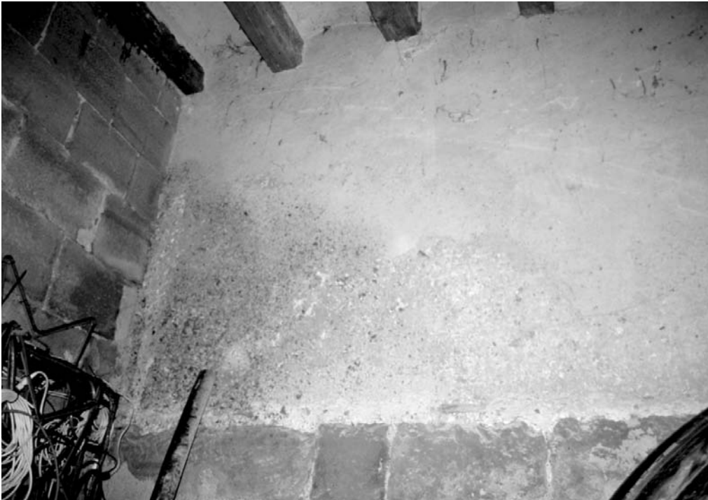
Foto 33. La primitiva muralla de tàpia sobre basament de carreus existent avui dia dins de la vella quadra del costat nord del castell de Barbens en el punt de contacte amb la torre angular. (Fot. J.R. González. Servei d'Audiovisuals de l'IEI).
