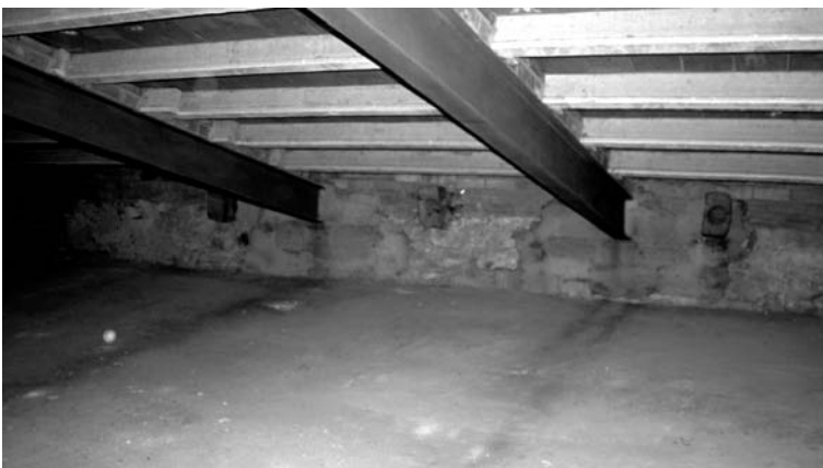
Foto 36. Sota l'actual coberta moderna del castell de Barbens s'aprecien els caps de les encavallades de fusta anteriors. (Fot. J.R. González. Servei d'Audiovisuals de l'IEI).
