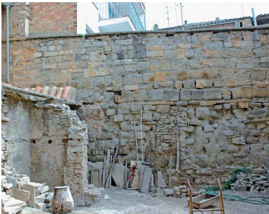
Fig. 19. Tram de muralla entre les cases núm. 7 i 9A del carrer de l'Hospital.
