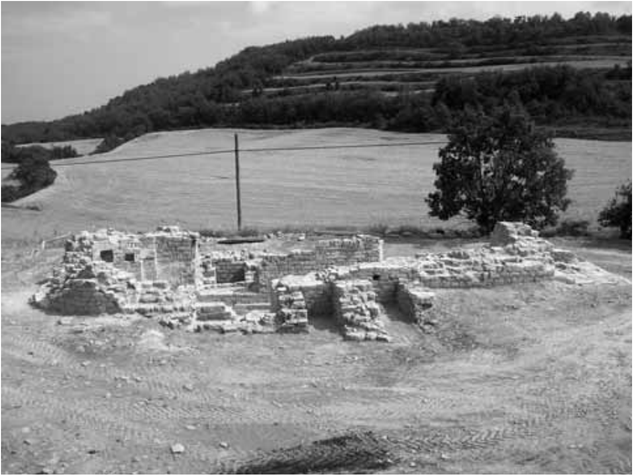
Figura 11. L'església des del nord un cop finalitzada la intervenció.
